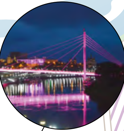
«Мост влюбленных» и трехуровневая набережная
